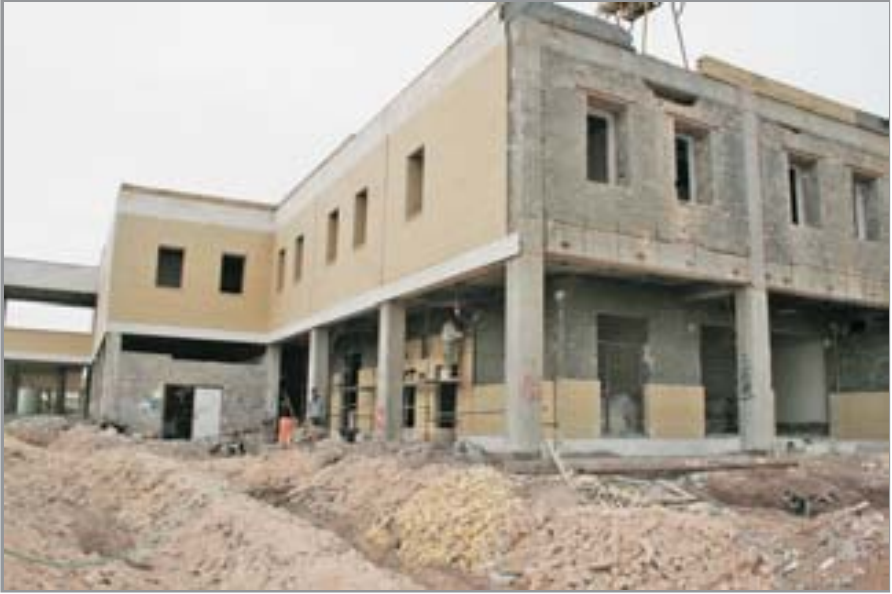
➡ بیمارستان در حال ساخت بندرلنگه
